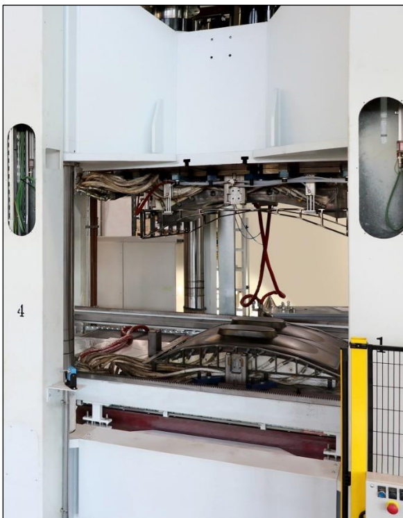
Ligne de production, mise en place des essais de moulage de panneaux latéraux (Photo : Cannon Group)
